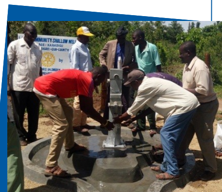
Vattenkommitténs medlemmar är med när pumpen installeras och vattnet kontrolleras.
