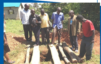
Inspektion av en dålig latrin!
