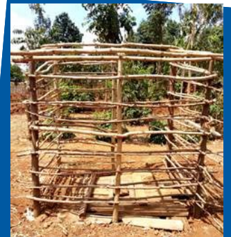
Hålet är grävt, väggar ska byggas.
