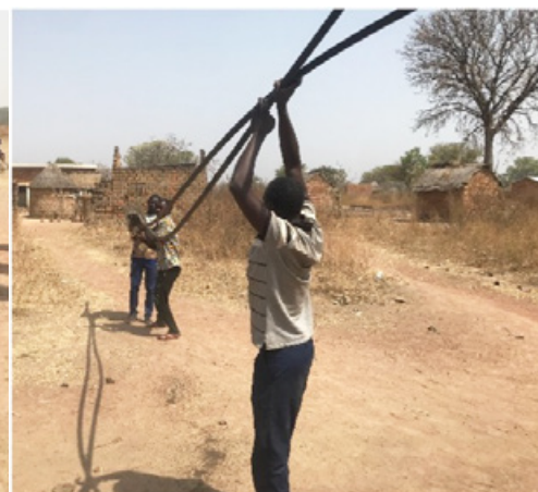
Slangar dras upp för att reparera tryckbehållare till en Vergnet pump
