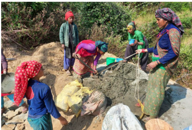
Konstruktionen med tanken fortsätter. Betongen blandas och det är byborna själva som gör det mesta av arbetet.
