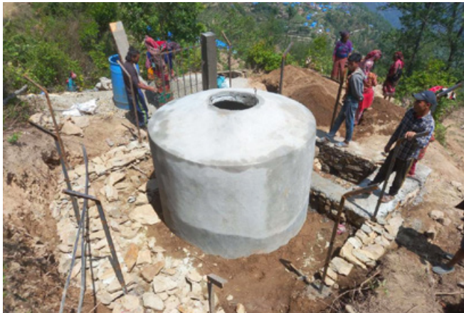
Nu är tanken mer eller mindre klar. Ett skyddsstaket installeras.
