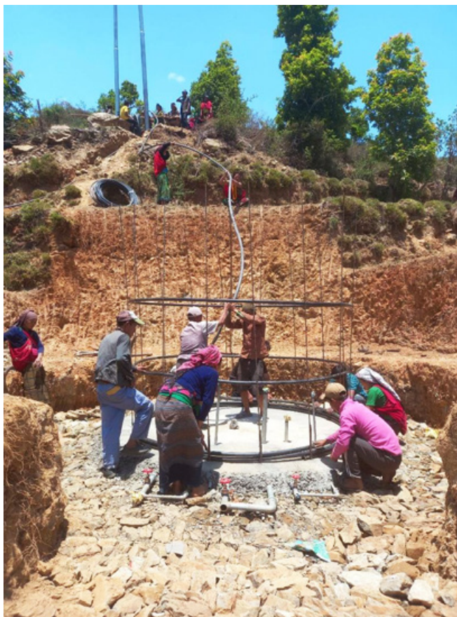
Konstruktionen med tanken fortsätter. Grunden är lagd och överdelen förbereds. Slangen till källan börjar också läggas.
