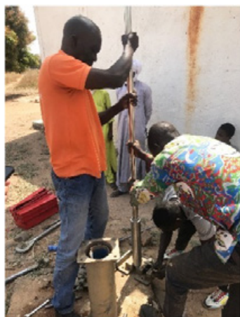
Ny cylinder och vattenrör monteras ihop till en India Mark II
