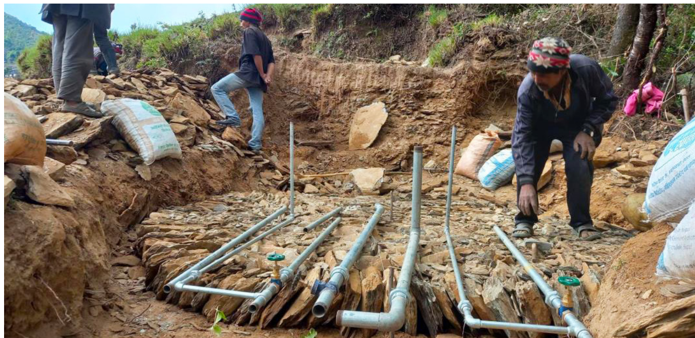
Här läggs själva grunden till mellanstationens buffert-tank. Byarna hjälper till i arbetet tillsammans med EFK/INF som guidar
