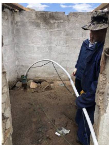
Den djupa brunnen i Murun village, före rehabilitering (2020)
