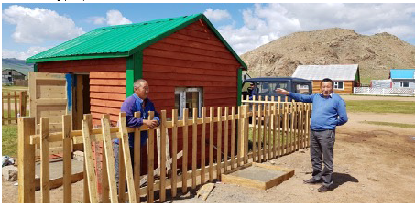
Den djupa brunnen i Murun village, efter rehabilitering (2020). Det är en stor skillnad mellan före och efter. Byborna är väldigt glada och tacksamma för att det nu blivit så bra.
